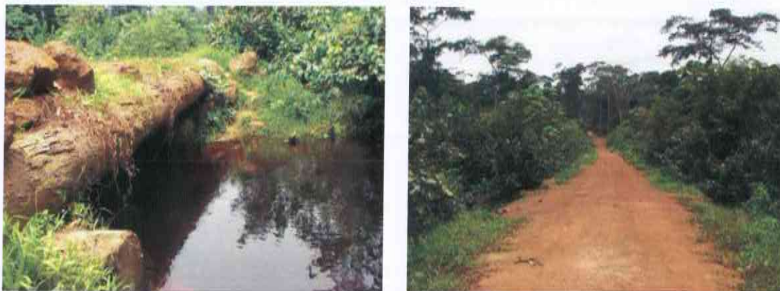
Image 4 : Pont et digue assurant la libre circulation de l'eau (source : JG Jourget)
