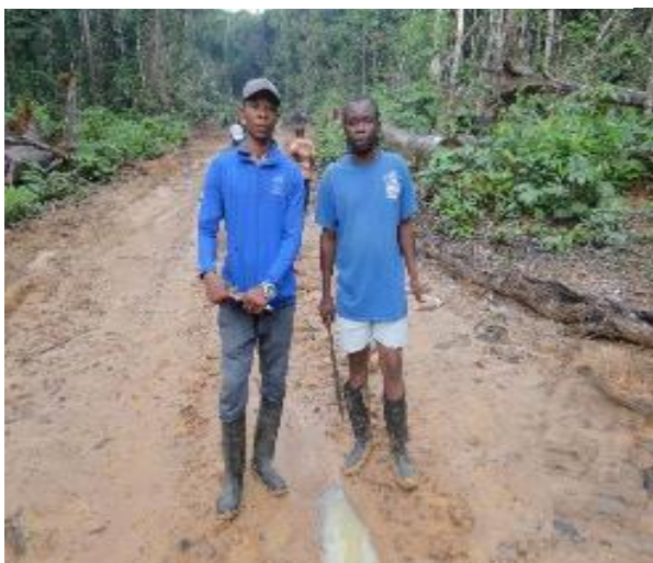
Photo 3. Absence de port d'Equipement de Protection Individuelle
