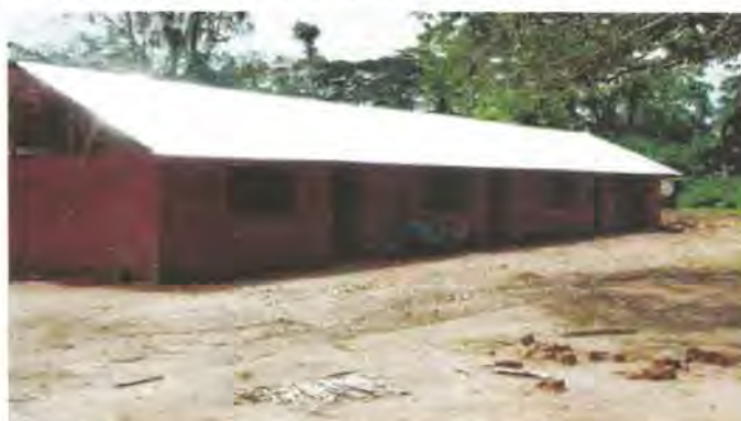
Photo 9 : Ecole de Boyela, en cours de construction
