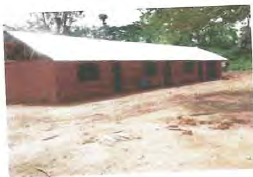
Photo 1 : Nouvelle école de Boyela (en cours de finition)
