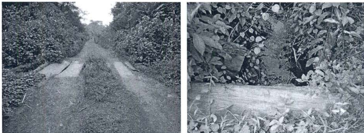
Photo 9 : Pont assurant la libre circulation de l'eau
