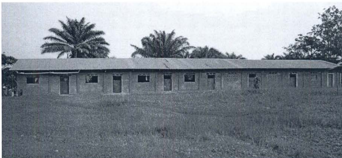
Photo 1 : Réhabilitation en cours de l'école d'Ingende – construite en 2006
