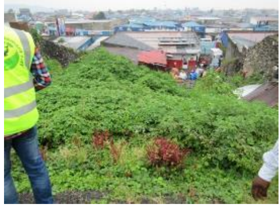
Site d'écroulement du mur de la Maison Paolos (Birere), le 30 avril 2018
