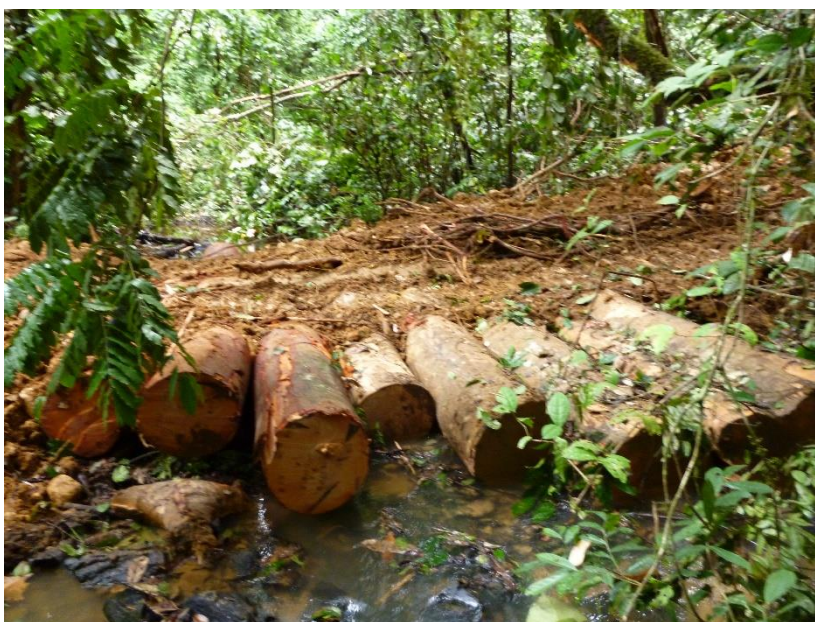
Photo 1 : Franchissement d'un cours d'eau
