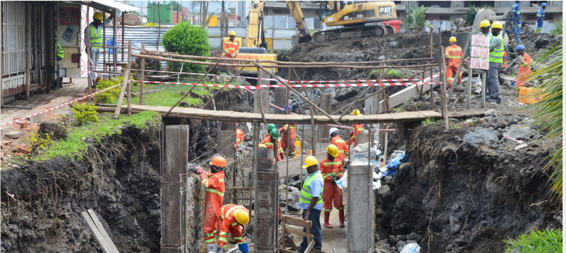
LEGENDE DE L'IMAGE: Travaux d'excavation et construction du collecteur dans le rond-point Bralima (communément appelé Tshukudu)
