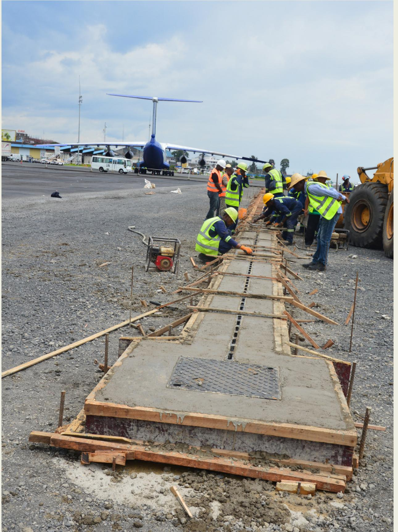
Vue des travaux de la pose de caniveau Qmax au niveau de l'extension de l'aire de stationnement des avions
